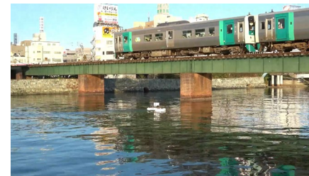
図4 水面の移動 JR鉄橋付近
