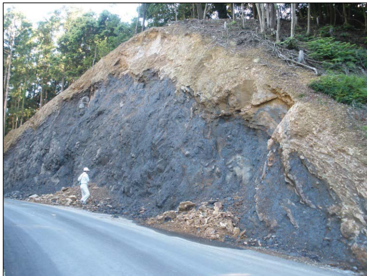
新第三系熊野層群の泥岩に見られる風化帯構造
