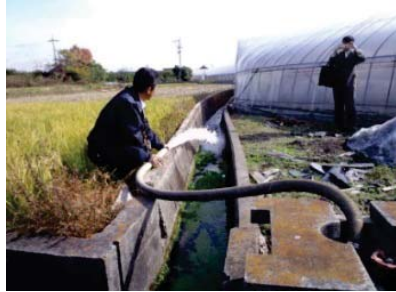
図1 管路式農業用水路
