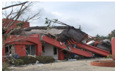
図1 東日本大震災の津波で全壊した宮城県の高齢者施設
