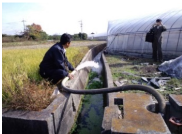
図1 管路式農業用水路
