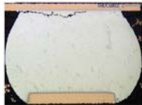
(b) エレクトロマイグレーションによる半断線例
