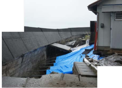
写真1 高潮により空洞化した防潮堤背面
