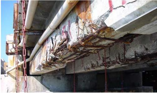
図1 塩害によるコンクリート構造物の劣化
