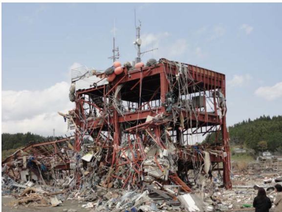
写真1 東日本大震災(南三陸町防災対策庁舎)
