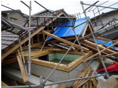
写真 熊本県益城町における木造住宅被害
