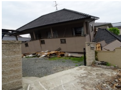
写真 熊本県益城町における木造住宅被害
