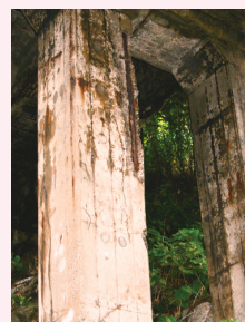
図-1 RC 構造物の鉄筋腐食による劣化
