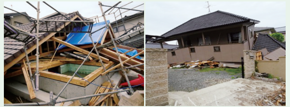
写真 熊本県益城町における木造住宅被害
