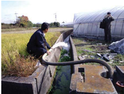
図1 管路式農業用水路
